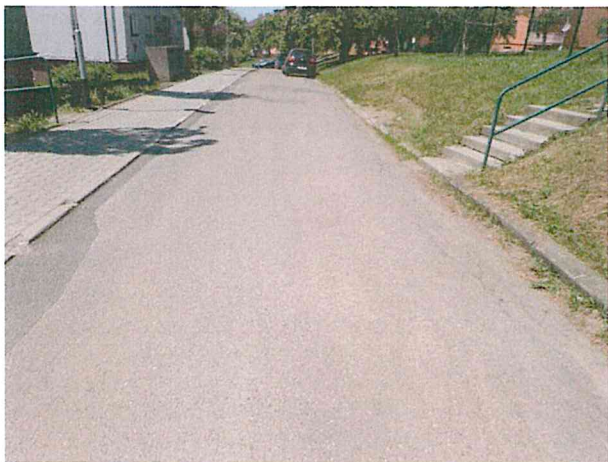
Vysprávkvy, síťové trhliny, plošná deformace vozovky
