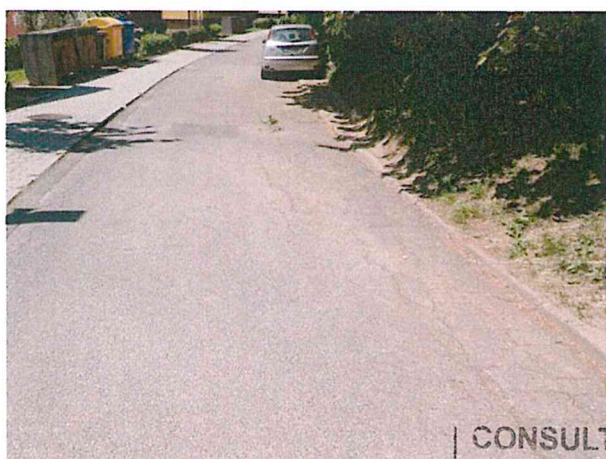
Síťové trhliny, plošná deformace vozovky
