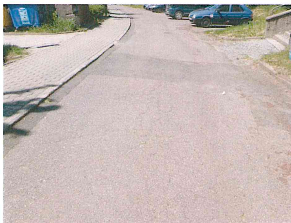
Hloubková koroze, vysprávkvy, mozaikové trhliny
