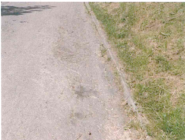
Síťové trhliny, plošná deformace vozovky
