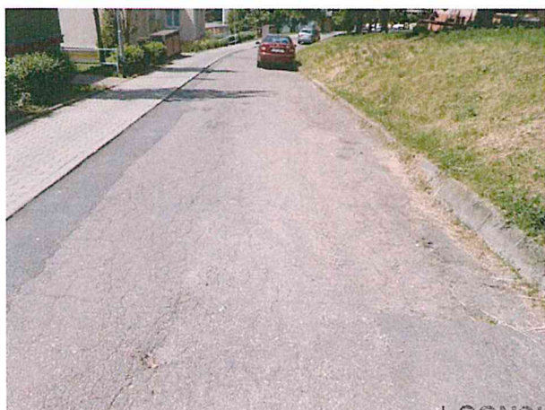
Mozaikové a síťové trhliny, plošná deformace vozovky
