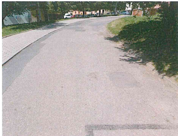
Hlubková koroze, vysprávkky, mozaikové trhliny
