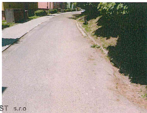
Hloubková koroze, plošná deformace vozovky
