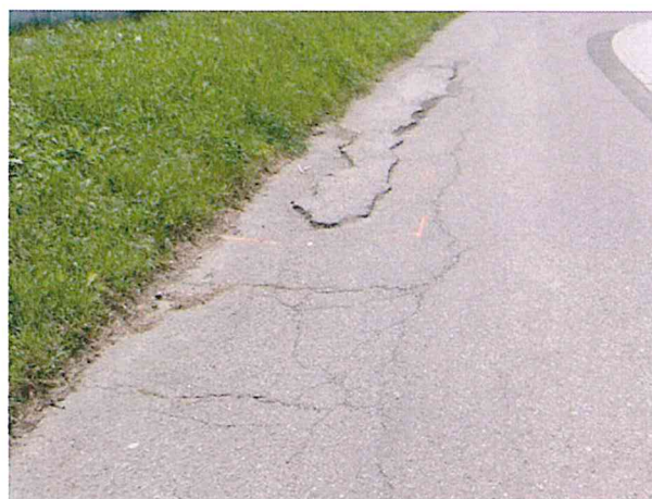
Vysprávký, síťové trhliny, plošná deformace vozovky
