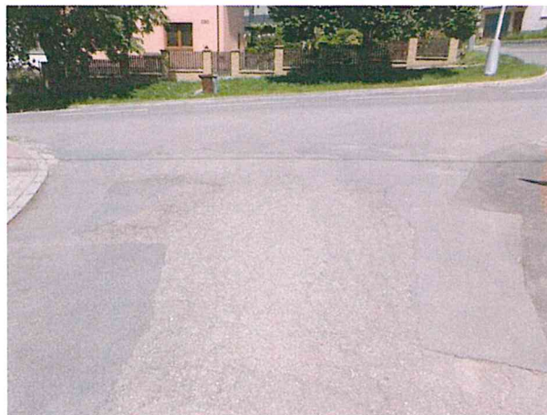
Konec úseku, vysprávkky, mozaikové trhliny, výtluky
