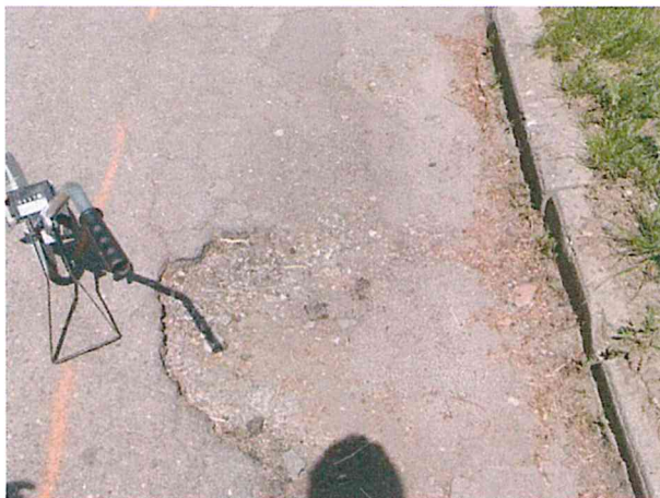
Mozaikové trhliny, výtluk
