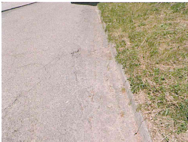
Mozaikové a síťové trhliny, plošná deformace vozovky
