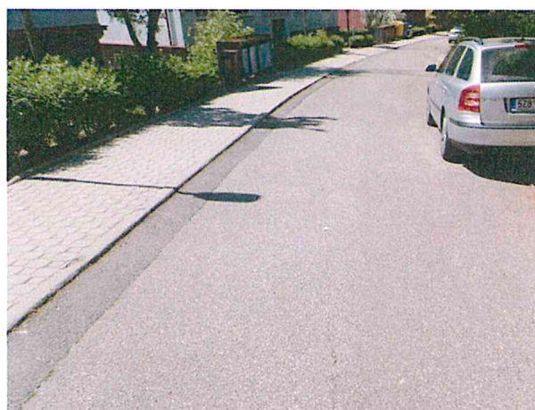
Hloubková koroze, vysprávký, podélná trhlina
