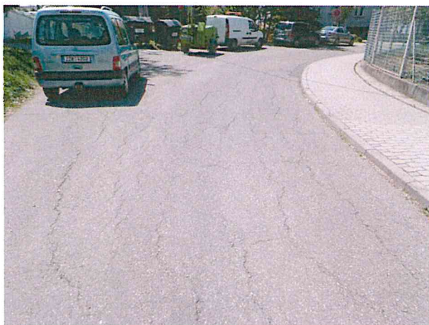
Podélné trhliny ve směrovém oblouku
