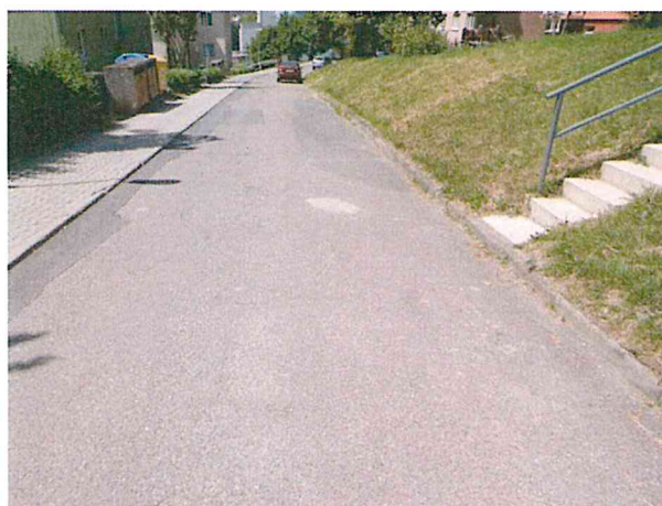
Hloubková koroze, vysprávkvy, mozaikové trhliny
