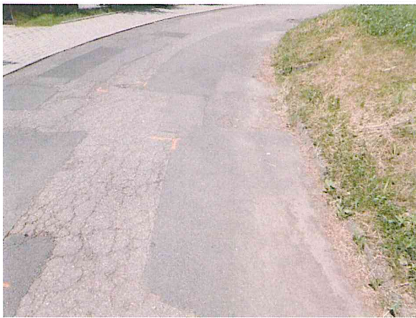
Hlubková koroze, vysprávkky, mozaikové trhliny
