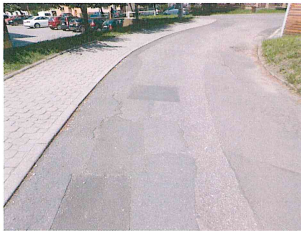
Hlubková koroze, vysprávkky, mozaikové trhliny
