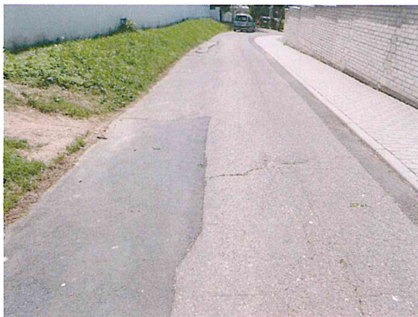
Vysprávký, podélná a příčná trhlina
